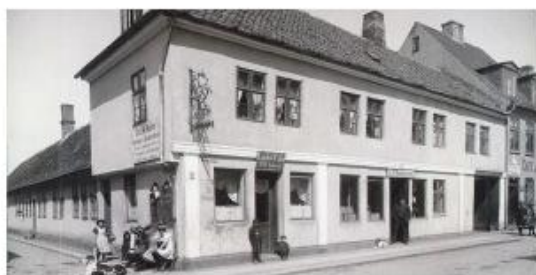
Den nedrevne ejendom på hjørnet af Skomagergade og Blågårdsstrædet. Foto: Kristian Hude.
